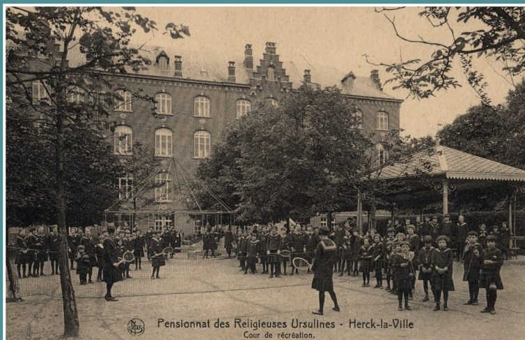
Achterzijde van het Ursulinenklooster tegenover de parking van het revalidatiecentrum.
